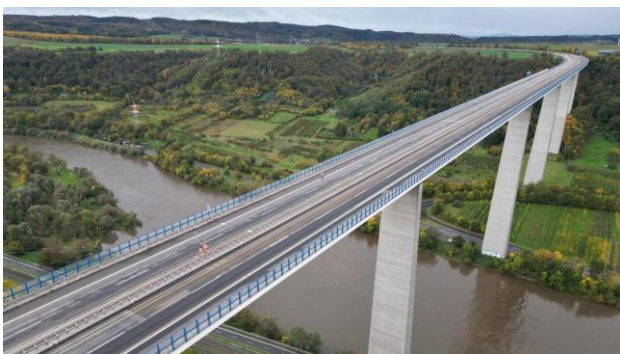
Vermessungsarbeiten während Vollsperrung
